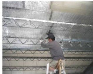
▲ 角鐵支架內隔熱施工 (黏貼固定)
