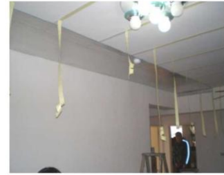
▲ 水泥屋頂內隔熱施工 (黏貼固定)
