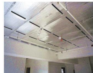
▲ 水泥屋頂內隔熱施工 (壓條外露釘槍固定)
