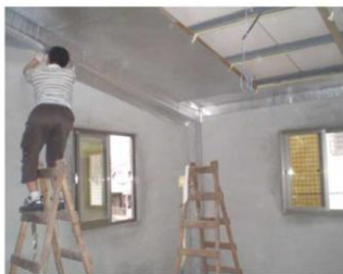
▲ 鐵皮屋頂內隔熱施工 (黏貼固定)
