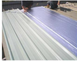
▲ 舊建物屋頂翻修隔熱施工
