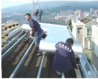
▲ 新建鐵皮屋屋頂外隔熱施工
