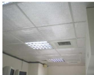
▲ 輕鋼架天花板下隔熱施工 (平鋪)
