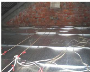
▲ 輕鋼架天花板上隔熱施工 (平鋪)
