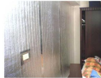
▲ 水泥牆面內隔熱施工 (黏貼固定)
