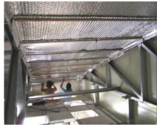
▲ 鐵皮屋頂內隔熱施工 (壓條外露釘槍固定)
