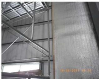
▲ 鐵皮牆面內隔熱施工 (壓條隱藏釘槍固定)
