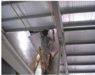
▲ 鐵皮屋頂內隔熱施工 (壓條隱藏釘槍固定)
