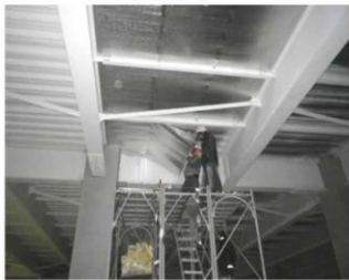
▲ 鋼承板屋頂隔熱施工 (黏貼固定)
