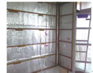
▲ 水泥牆面內隔熱施工 (釘槍固定)
