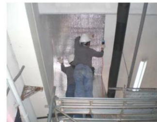
▲ 水泥屋頂內隔熱施工 (壓條隱藏釘槍固定)
