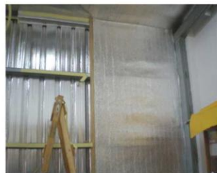
▲ 鐵皮牆面內隔熱施工 (黏貼固定)
