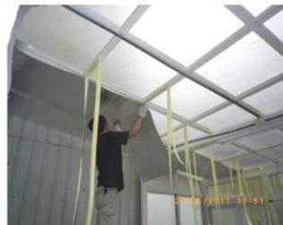
▲ 採光罩隔熱施工 (黏貼固定)
